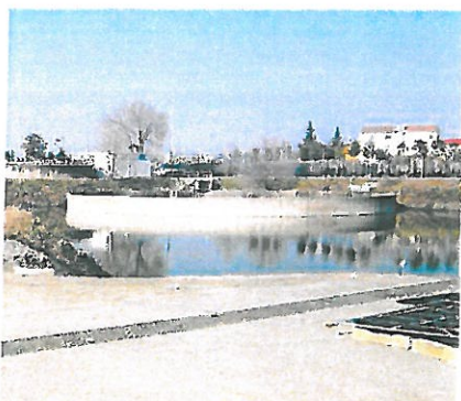
L'opera. L'impianto di via Tirale è stato completato
