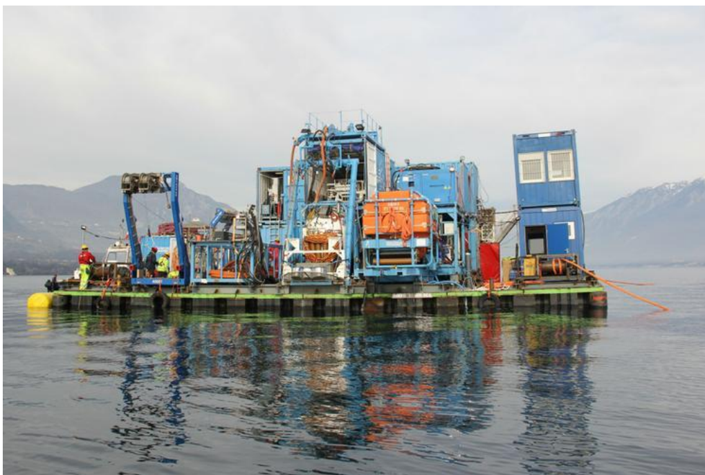
La piattaforma usata per i lavori sulle tubature sublacuali - Foto © www.giornaledibrescia.it
